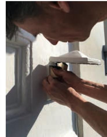
Aménagement réalisé rue Dethy à Saint-Gilles. Mesure des trous de boulin / mise en place d'un carré d'isolant (fibre de bois) / collage de pièces en bois / Séchage
